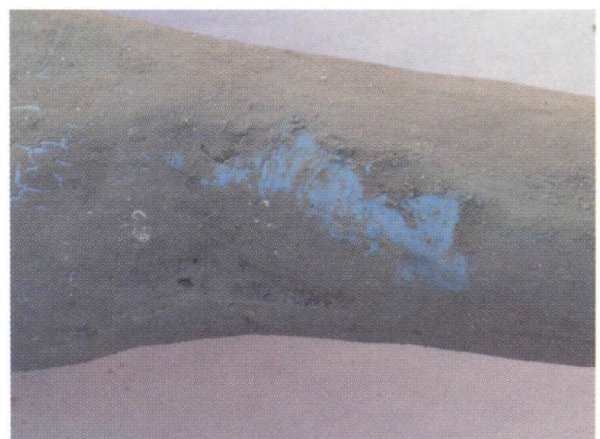
4. Detall que mostra l'estrat de fang empastat amb aigua i oli d'oliva i la repintada total d'esmalt sintètic de color gris.
